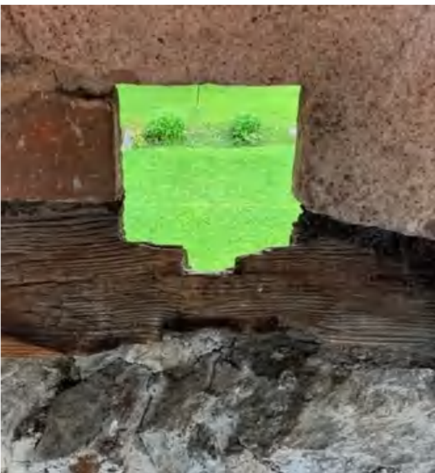
Schiescharte in der Wehranlage von Glurns
